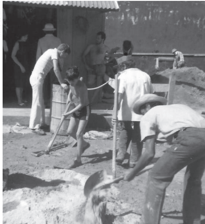
Construção do Armarinho Buritis
